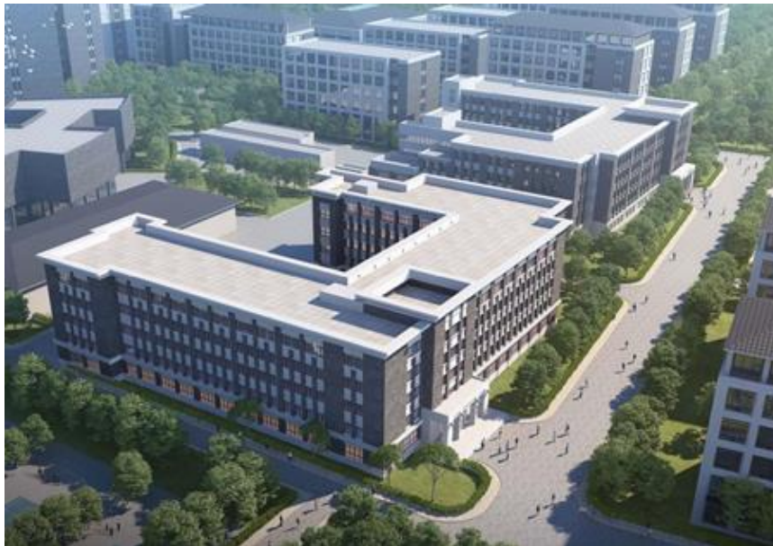
北京大学新燕园校区 3 号楼纳光电子前沿科学中心
